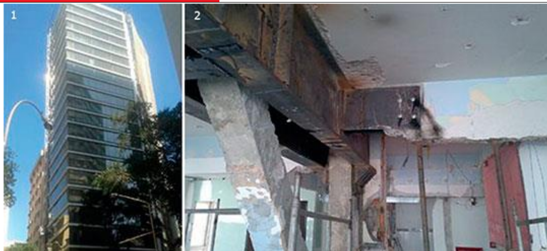
1. Reorganização estrutural foi feita no 21º andar do edifício Cardeal Leme, na avenida Rio Branco, no Centro do Rio de Janeiro. 2. As novas vigas metálicas foram ligadas à estrutura original por meio de consoles chumbados. Como não se tratavam de cargas novas, não foi necessário adaptar a estrutura original.
