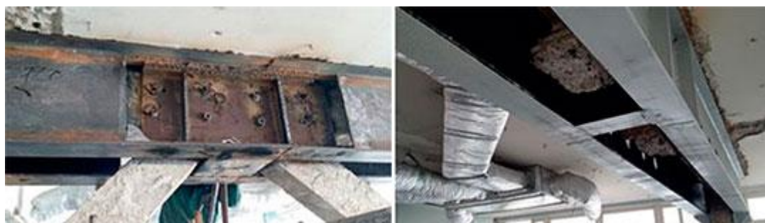
1. Reorganização estrutural foi feita no 21º andar do edifício Cardeal Leme, na avenida Rio Branco, no Centro do Rio de Janeiro. 2. As novas vigas metálicas foram ligadas à estrutura original por meio de consoles chumbados. Como não se tratavam de cargas novas, não foi necessário adaptar a estrutura original.
